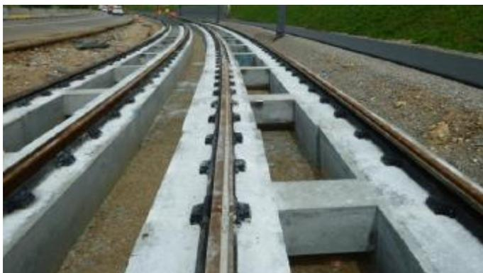
*Plateforme tramway avec une structure sur longrine béton*
